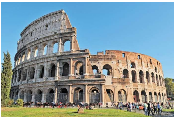
ローマ時代のローマンコンクリートで構築されたコロッセオと水道橋
